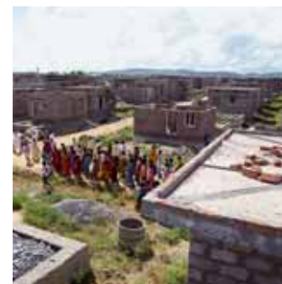
1.150 Häuser für die Familien der Kalköfen-Arbeiter entstehen hier gerade mithilfe der Regierung. Für 750 Häuser gibt wortundtat den Familien einen Zuschuss.
